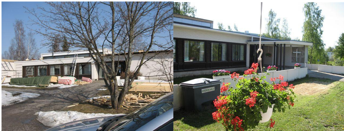
Seurakuntatalon katon remontti ja julkisivuun tehdyt työt sujuivat suunnitellusti
