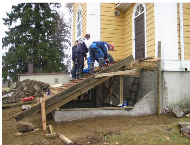
Sakastin porrastyömaa etenee.
