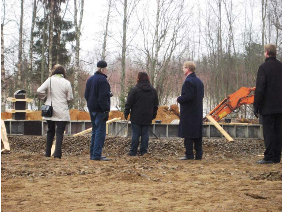
Tästä se lähtee! Uuden seurakuntatalon työmaalla pidettiin rukoushetki jumalanpalveluksen jälkeen 3.4.2011.
